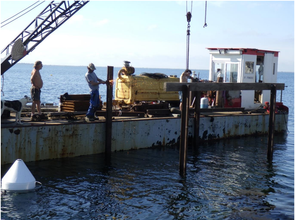
Pose du quatrième pieu
