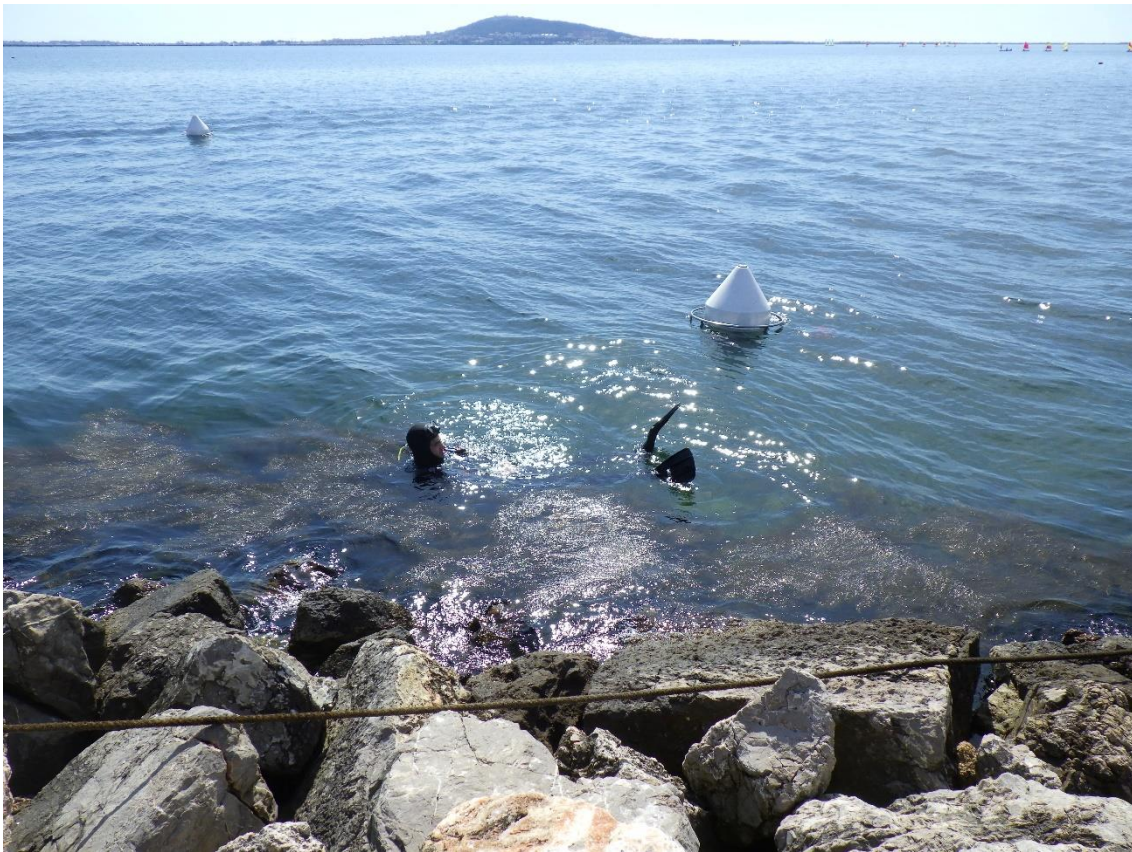
Repérage des points pour les pieux au sol
